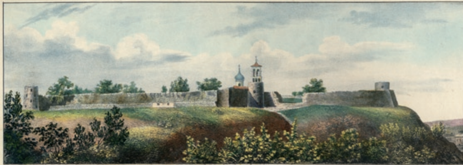
Съ южной стороны.
